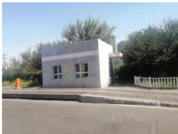
现状地磅及磅房
