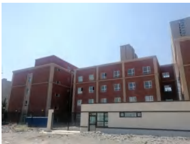
拟新建转运站选址西侧的市 131 小学
