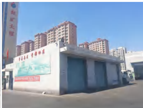
现状垃圾转运车车库
