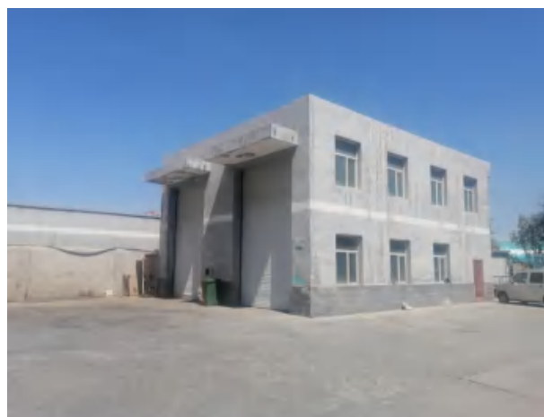
站内拟改造厨余垃圾转运站的闲置车间
