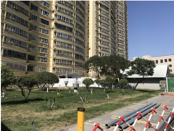
现场（锅炉房地面入口处）
