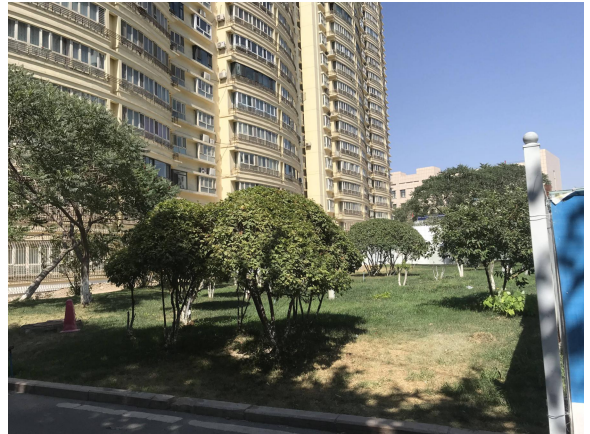
现场（锅炉房地面）
