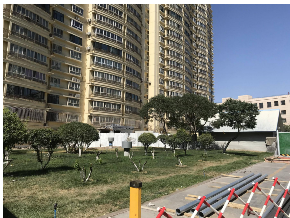
现场（锅炉房地面入口处）
