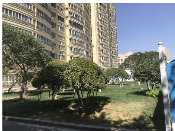
现场（锅炉房地面）
